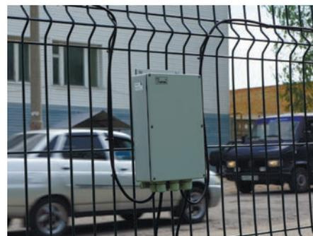
Das Erfassungsfeld entsteht aus zwei Flanken. Je Flanke werden direkt am Zaun zwei Sensorkabel befestigt, die an eine Auswerteeinheit angeschlossen werden. Jedes Sensorkabel ist einzeln mittels Software einstellbar, dank was erhöht sich die Störungsstabilität. Als Sensorkabel wird ein spezielles Kabel verwendet, das hohe Detektionswahrscheinlichkeit und Störnunempfindlichkeit gewährleistet.
